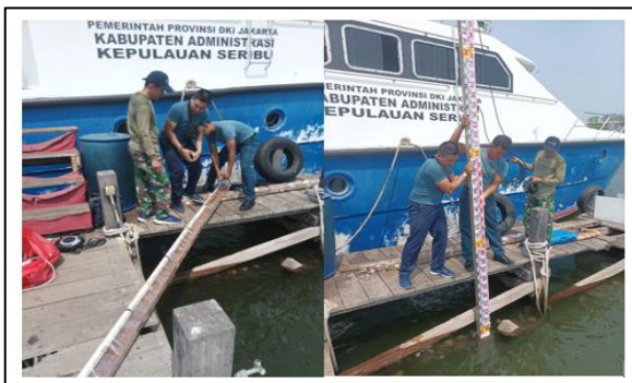
Gambar 12. Pemasangan tiang palem.
