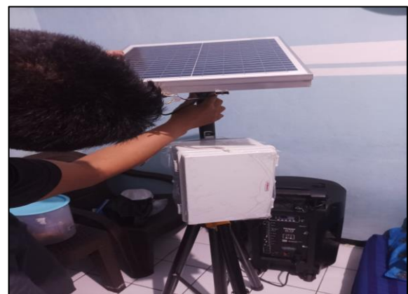
Gambar 10. Memasang panel surya.
