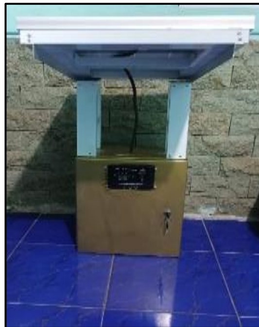
Gambar 12. Memasang solar cell
